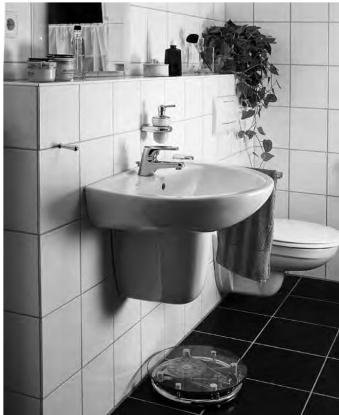
Завершенная перегородка с санфаянсом
