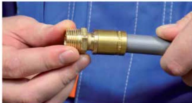
Для аксиальных латунных фитингов СИНИКОН необходимо использовать подвижные гильзы СИНИКОН. При использовании подвижных гильз сторонних производителей герметичность соединения не гарантируется и претензии не принимаются. После монтажа трубопровод должен пройти гидростатические испытания в соответствии с требованиями СП 73.13330.2016.
