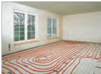
Рис. 15.5-1 Система крепления труб с помощью гарпун-скоб
