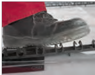
Рис. 15.5-11 Вдавливание фиксирующих шин RAUFIX в конструкцию пола
