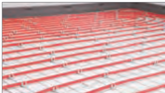
Рис. 15.5-22 Система крепления труб на арматурной сетке
