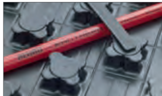
Рис. 15.5-18 Фиксирующие скобы
