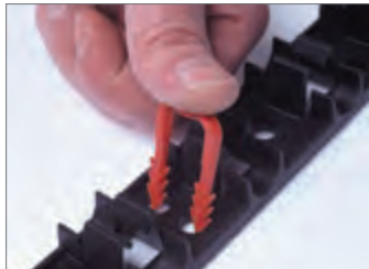
Рис. 15.5-12 Вдавливание гарпун-скоб в конструкцию пола
