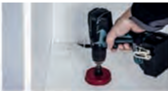
Шаг 2 Просверлите вентиляционное отверстие и установите блок RE.SOURCE в шкаф.
