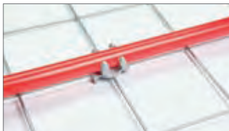
Рис. 15.5-27 Крепление труб 20 мм вдоль основания клипсы
