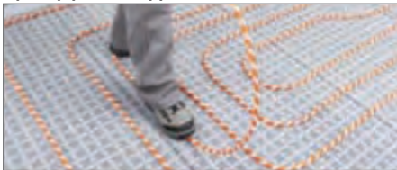
Пример укладки трубы RAUTHERM SPEED
