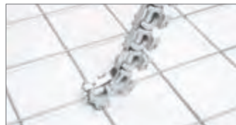
Рис. 15.5-32 Установить штангу с магазином поворотных клипс
