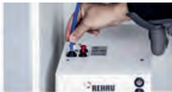
Шаг 3 Подключите трубки холодной и горячей воды к блоку, вставьте вилку устройства в розетку.
