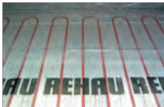
Рис. 15.6-1 Система укладки труб на теплоизоляционных матах TS-14
