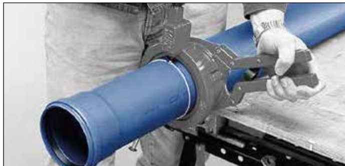
Обрезание до нужной длины труборезом с фаскоснимателем
