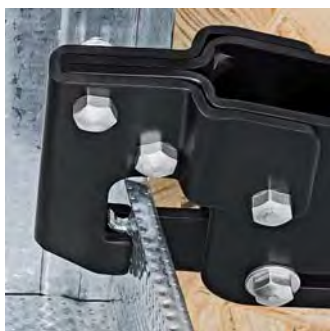
Установка инструмента на оба соединяемых профиля
