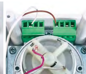
Фото 11. Подключение датчика к электроприводу
