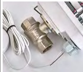
Фото 8. Завести провод датчика в кабельный ввод
