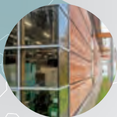
Завод по производству фитингов из нержавеющей и углеродистой стали, г. Шмидефельд под Дрезденом, Германия
