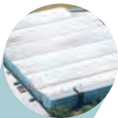
Завод по производству труб, г. Берлин, Германия
